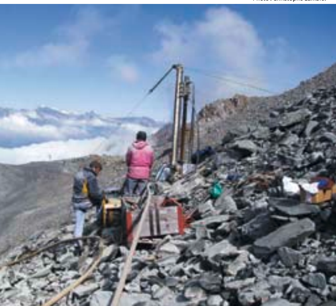
Travaux de forage dans les déblais gelés des Attelas en automne 2008.
